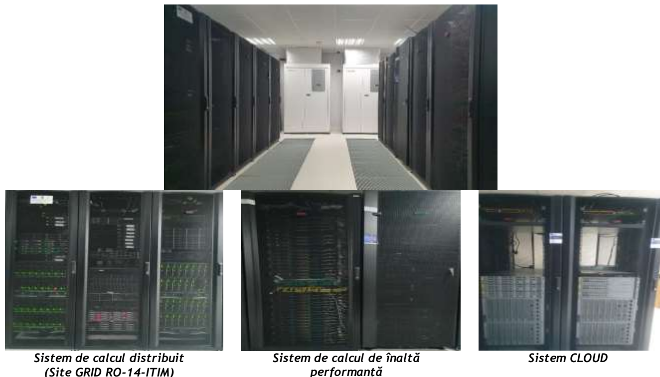
Fig. 2 Structura Datacenter PACTE
